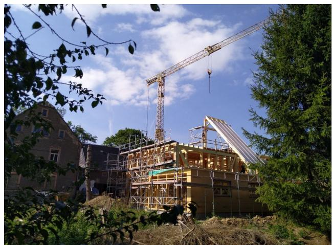
Langsam nahm das Bauwerk seine Form an. Das transparente Mittelstück wurde in der darauf folgenden Woche durch die beiden angrenzenden Dachflächen ergänzt. Nachdem es jetzt von oben dicht ist, werden die Wände, Fläche für Fläche, mit Strohballen gedämmt. Dann darf der Winter kommen ;-)
