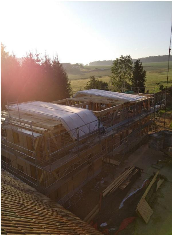
Am nächsten Mittag lagen die zwei bespannten Dachhälften für den Mittelteil des Gebäudes einsatzbereit auf dem noch flachen Dach des Rohbaus.
