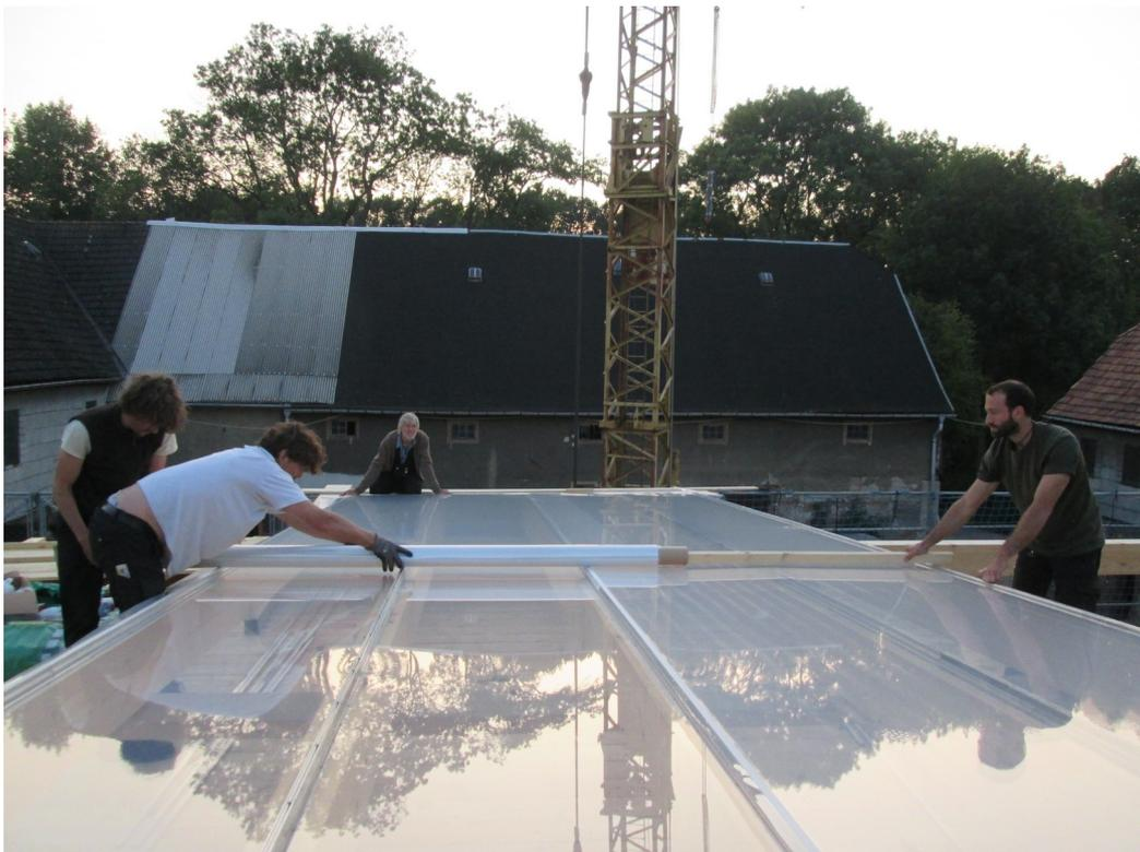
Das Anbringen des Deckprofils auf der zweiten Folienlage war dann eine etwas größere Herausforderung, da es nicht mehr möglich war zwischen den Balken zu stehen.
