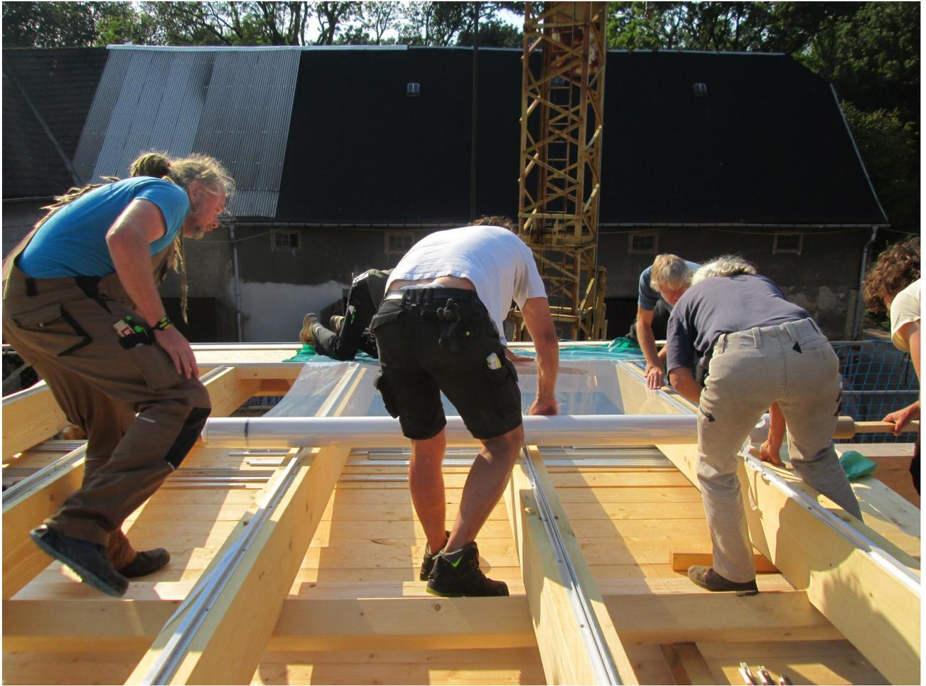
Auf der ersten Lage Folie wurde dann das Zwischenprofil geschraubt. Damit wurde die Folie gespannt und gleichzeitig entstand die Ebene für die zweite Lage Folie.
