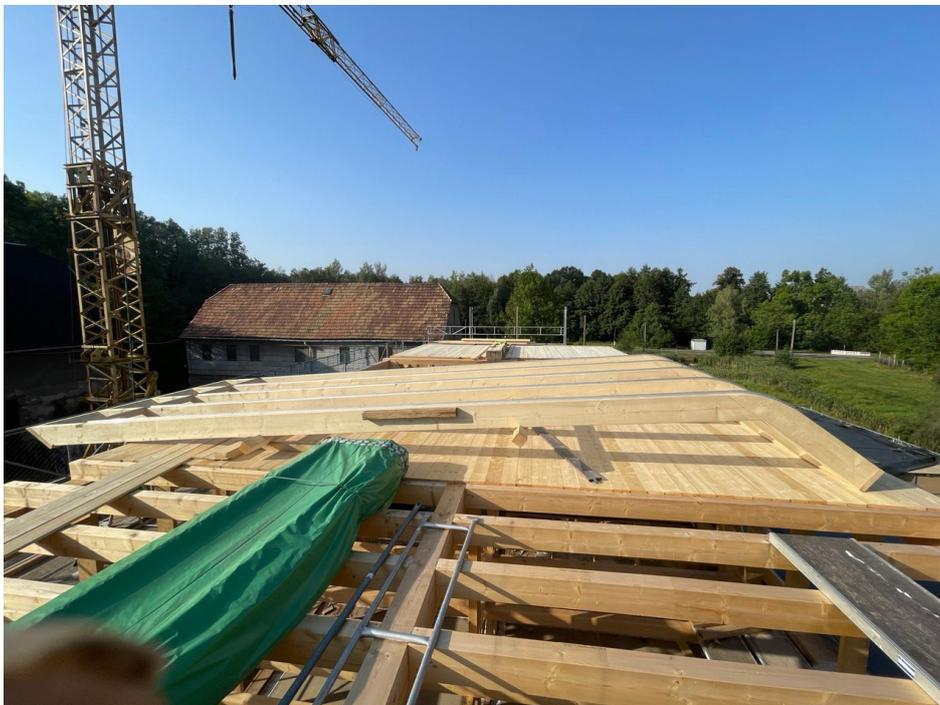
Der nächste Schritt war die Vorbereitung der Profile mit deren Hilfe die Folie auf dem Holzgerüst befestigt werden kann. Mehrere hundert Meter durften dafür gesägt, geschlitzt, gebohrt und geschliffen werden. Dann konnte das unterste Profil auf der Holzkonstruktion verschraubt werden. Das Zwischenprofil und das Deckprofil konnten wir dann probeweise schon mal darüber legen.
